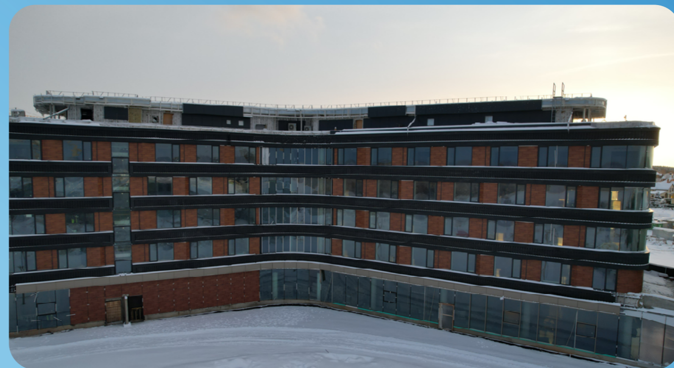
Завершение наружной отделки 2 корпусов гостиниц
