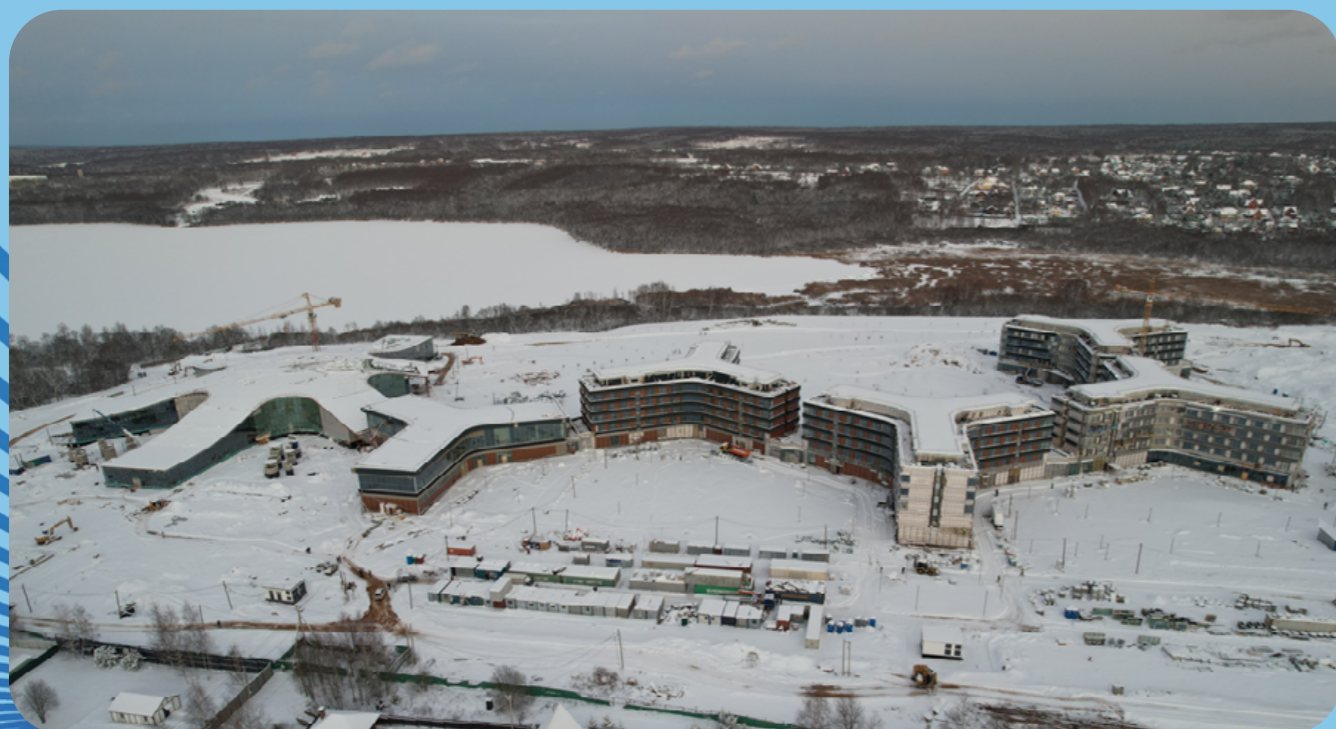
Общий план строительства
