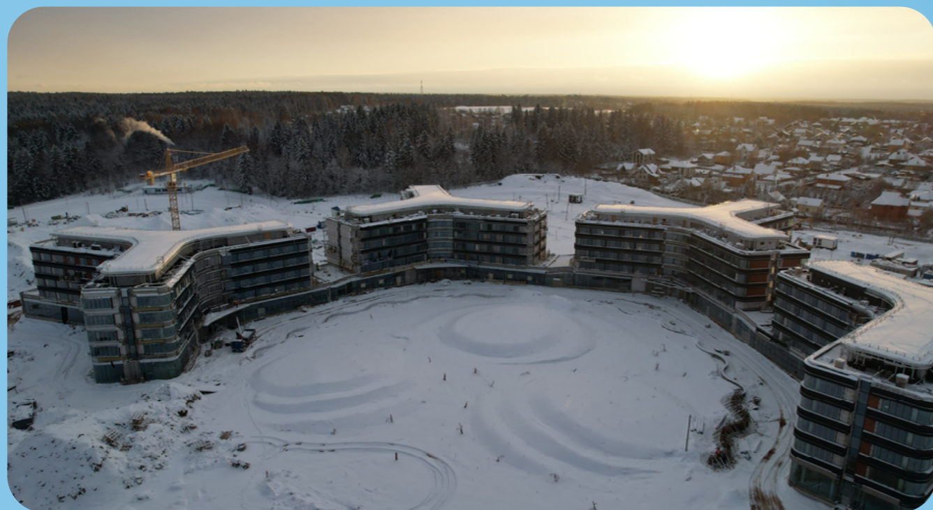
Общий план строительства
