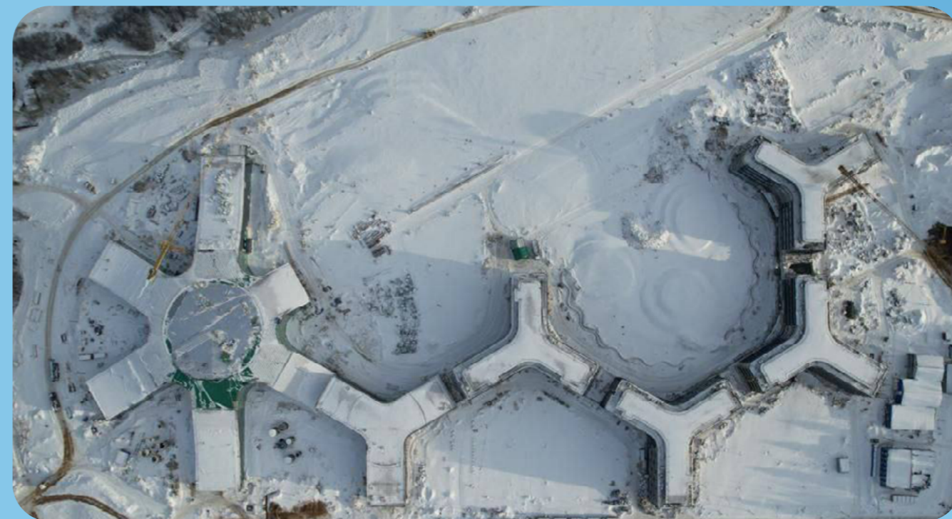
Общий план строительства
